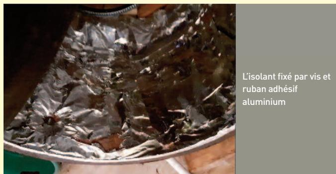
L'isolant fixé par vis et ruban adhésif aluminium
